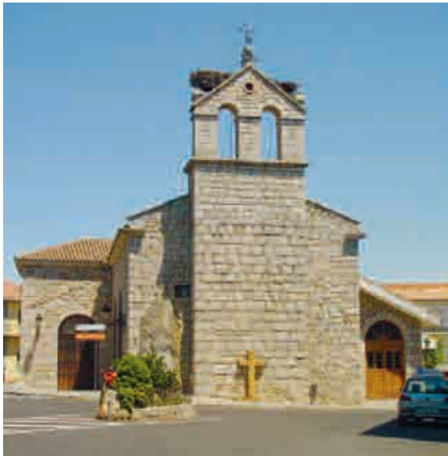
[Plaza de la Caldereta]
