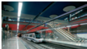
Estación de Nuevos Ministerios
